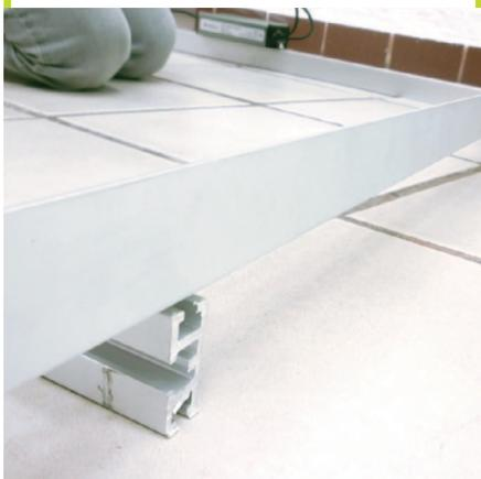
Con ambos soportes triangulares fijados a los rieles ya tienes tu base para dos paneles econotecnica.
