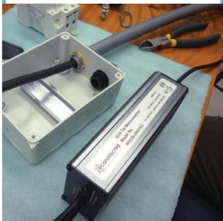
23. Introduce los dos cables de cada inversor por la entrada del conector de glándula.
