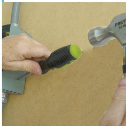
57. Cuando se afloje, saca el sobrante con unas pinzas. Asegúrate que el conector entre en el hoyo,
