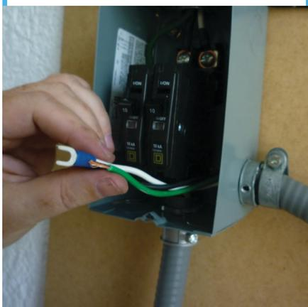
67. Identifica las conexiones inferiores donde colocaras los cables.
