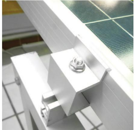
4. Desliza hasta la mitad de los rieles E otro tornillo SS 1/4" X 2", donde se colocara el separador "U"
