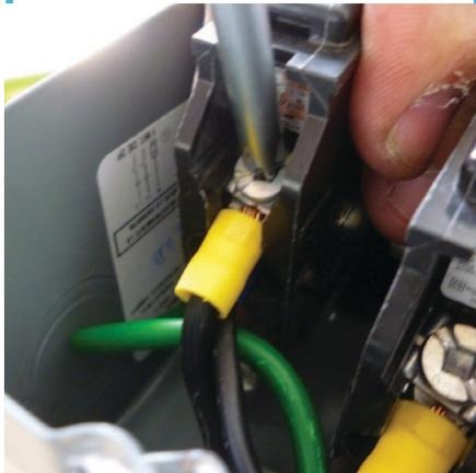
69. Para la conexión a tierra (el cable verde) Pasa por debajo de las pastillas el cable verde.
