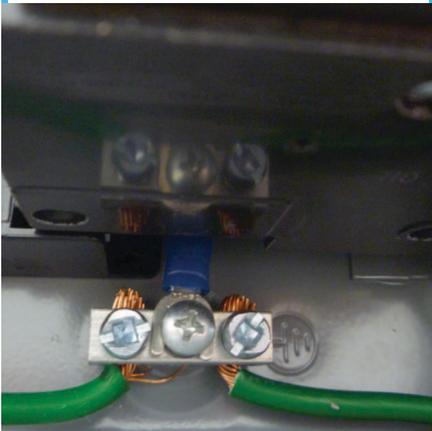
70. Afloja el segundo tornillo y conecta el cable.
