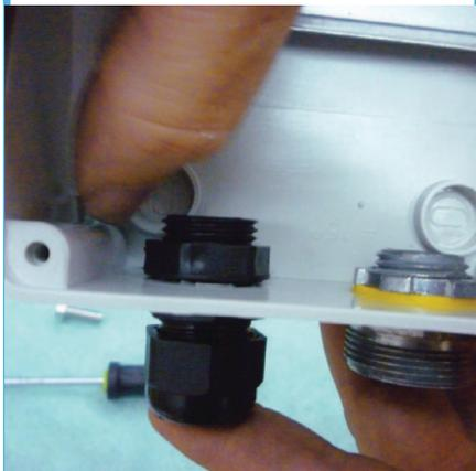
12. Coloca la tuerca en el tubo Liquid tight, de aquí se conectara a la red eléctrica más adelante.
