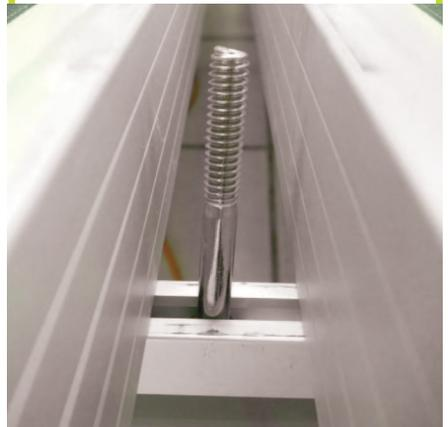
7. Coloca una "U" sobre los tornillos y junta los paneles solares hasta que toquen el separador.
